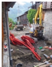
Reprise des réseaux à Tincave
