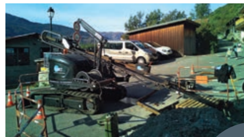
Curage d'une conduite à Bornoua (Villemartin)
