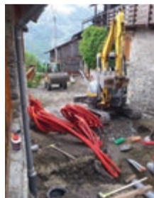
Reprise des réseaux à Tincave
