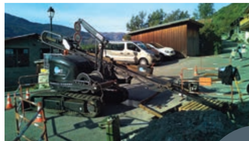
Curage d'une conduite à Bornoua (Villemartin)
