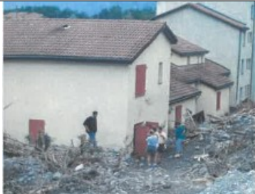
Les bâtiments ayant des façades renforcées peuvent résister aux contraintes imposées par l'écoulement et les matériaux charriés.
