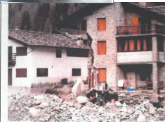
Les constructions normalement fondées ne sont pas détruites par l'affouillement
