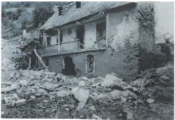
Les contraintes dynamiques imposées par l'écoulement et les matériaux charriés peuvent détruire les bâtiments exposés.
